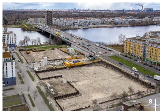
7 | München Bauer ist mit weiteren Arge-Partnern am Bau der 2. Stammstrecke in München beteiligt – ein gigantisches Infrastrukturprojekt. Die Startbaugrube an der Donnersbergerbrücke für die Tunnelbohrmaschine wurde bereits fertiggestellt.
