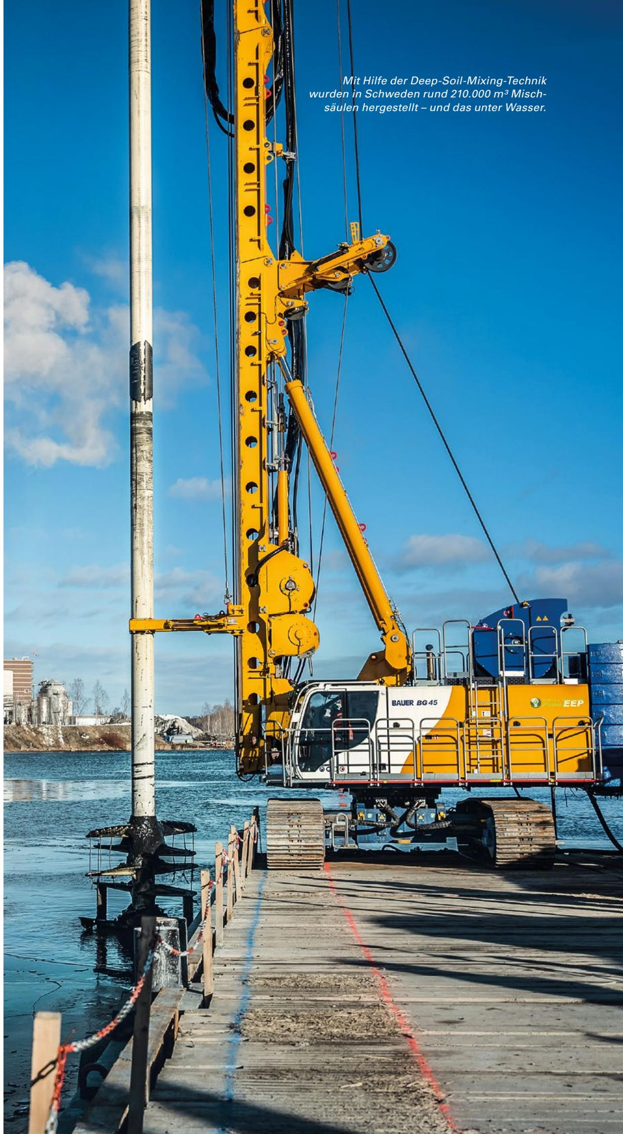
*Mit Hilfe der Deep-Soil-Mixing-Technik wurden in Schweden rund 210.000 m<sup>3</sup> Mischsäulen hergestellt – und das unter Wasser.*
