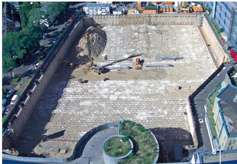
**6 | Köln** Für den Neubau des Centrus für Familiengesundheit (CEFAM) der Uniklinik Köln verrichtete Bauer zur Erstellung der 14 m tiefen Baugrube mehrere Spezialtiefbauarbeiten, u. a. 8.000 m<sup>2</sup> Mixed-in-Place-Verbauwand.
