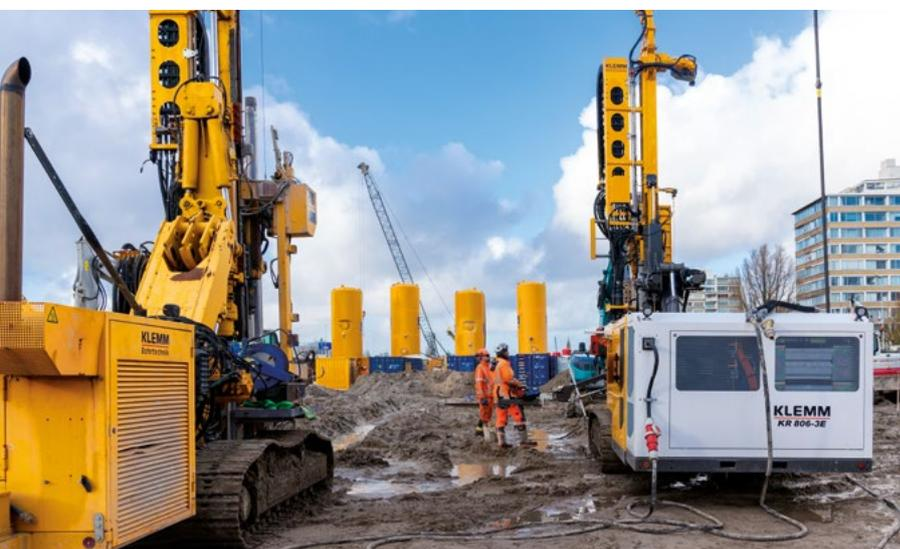
Das elektrische Ankerbohrgerät KLEMM KR 806-3E überzeugte im direkten Vergleich auf der Baustelle.
