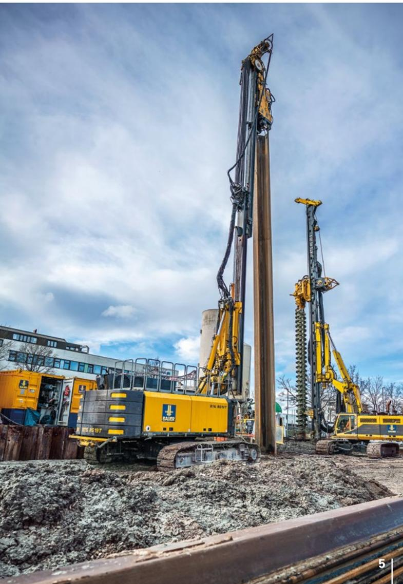
**5 | Garching** In der Schleißheimerstraße wurde eine 8 m tiefe Baugrube errichtet. Hierfür führte Bauer 3.000 m<sup>2</sup> Spundwand, 150 Verbauanker, 500 m<sup>3</sup> HDI-Abdichtung sowie 1.000 m<sup>2</sup> statische Mixed-in-Place-Wand aus.
