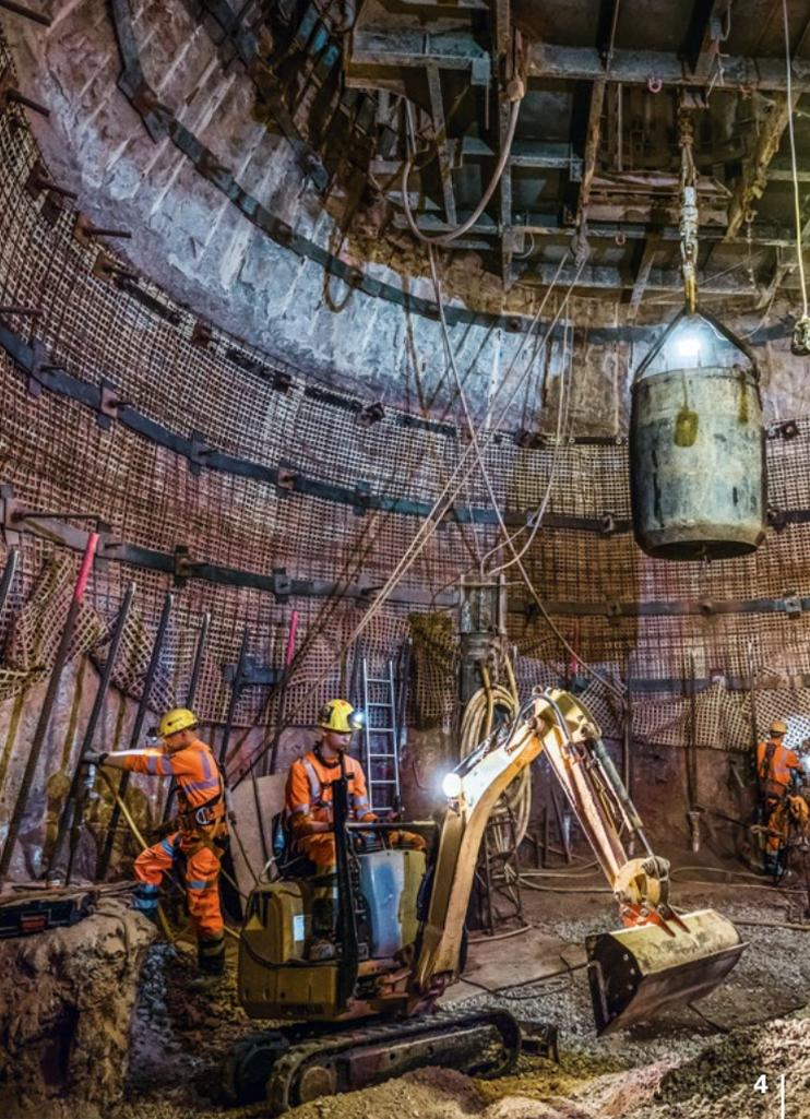
**4 | Halle-Teutschenthal** Zur langzeit-sicheren Verwahrung des Schachts Saale führt Schachtbau Nordhausen Sicherungsarbeiten durch. Es werden ein Ankersystem aus mehr als 8.600 m Injektionsbohrankern installiert, ein 22 m langer Stahlblechzylinder verbaut und Hohlräume verfüllt.
