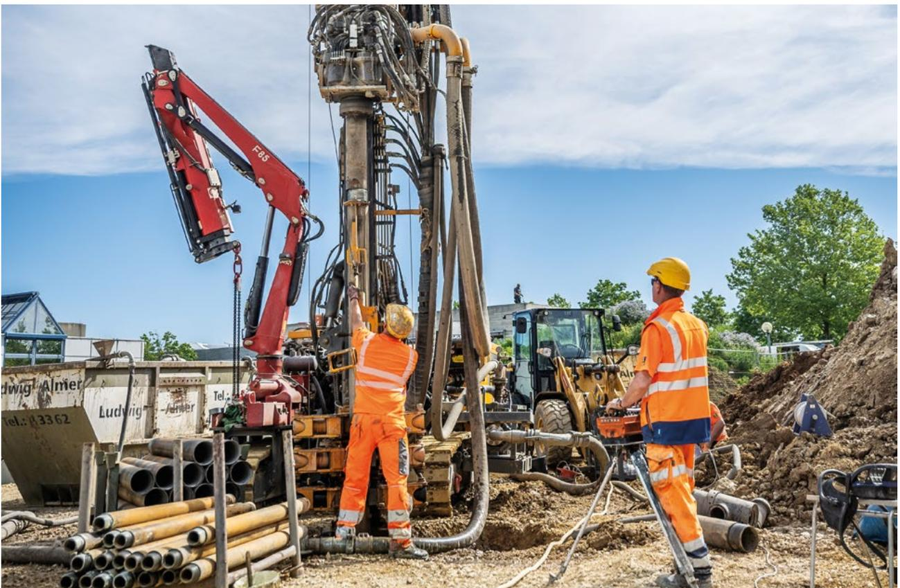
**Regensburg** Präzision war bei der Herstellung einer Erdwärmesondenanlage am neuen Modulbau der Hochschule Regensburg gefragt. Mit einer KLEMM KR 805-3GW hat Bauer Resources auf engstem Raum 24 Erdwärmesonden eingebaut.
