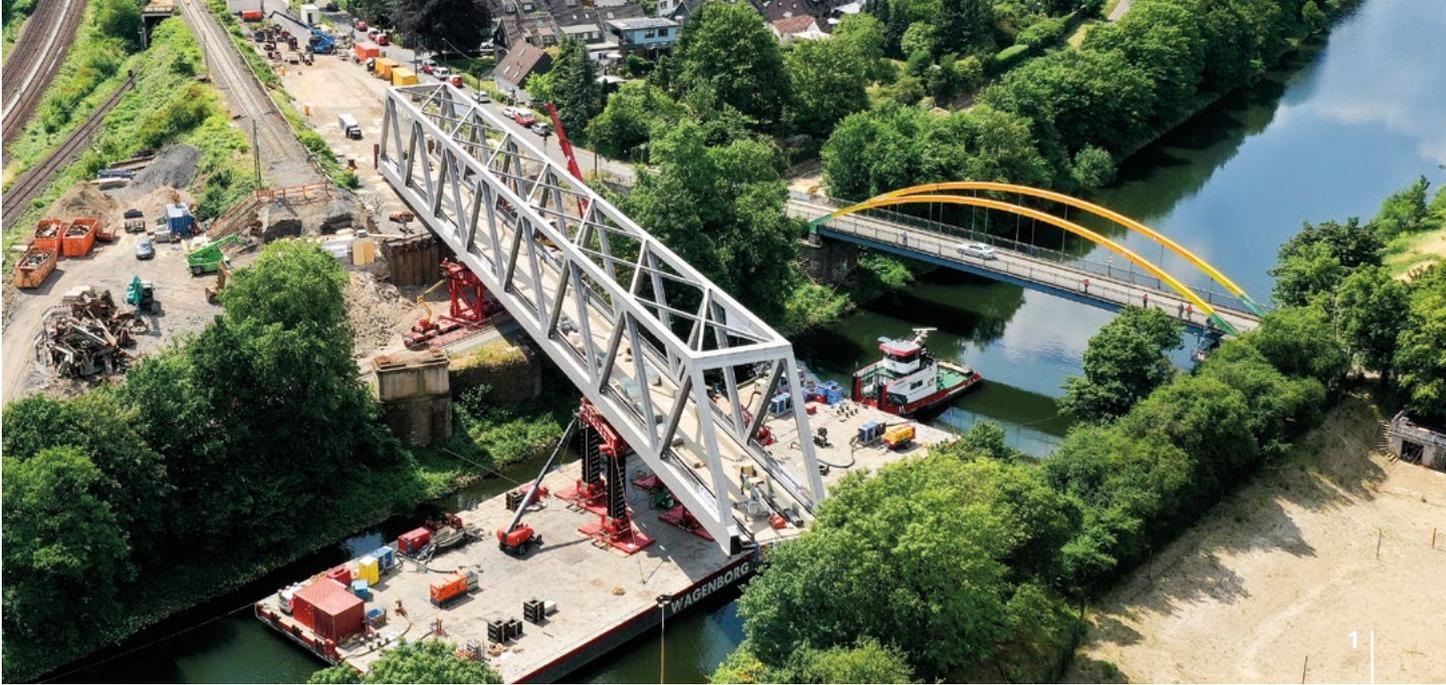
**1 | Duisburg** In einer Arge hat Schachtbau Nordhausen den Ersatzneubau der „Violetten Brücke“ in Duisburg realisiert. Die neue Ruhrkanalbrücke präsentiert sich als eindrucksvoller 110 m langer und 8 m breiter eingleisiger Fachwerküberbau mit einem Gewicht von 900 t.
