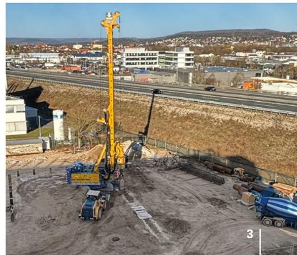
**1 | Bad Wiessee** Im Rahmen des Neubaus der Ortsmitte in Bad Wiessee errichtete Bauer eine überschnittene Bohrpfahlwand, bohrte Gründungspfähle und führte weitere Ankerarbeiten aus.
