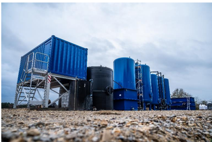
(1) Bauer Resources errichtete eine maßgeschneiderte Grundwasserreinigungsanlage auf einem Militärgelände in Manching.
