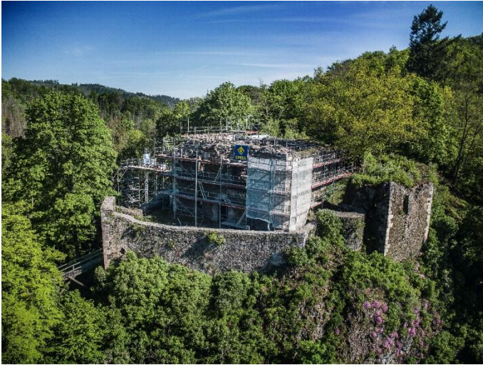
(2) Die Burgruine Hohenberneck wurde von März 2021 bis Dezember 2022 umfangreich saniert und im Mai 2023 wieder der Öffentlichkeit zugänglich gemacht.
