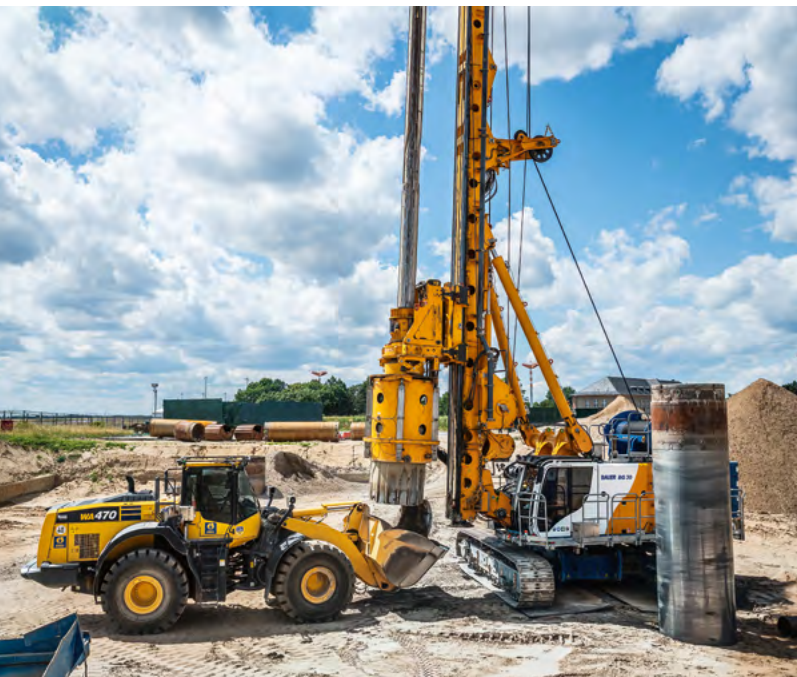
Viele Projekte, noch mehr Synergien: Nicht nur am Flughafen Berlin-Schönefeld arbeiten Resources- und Spezialtiefbau-Kollegen Hand in Hand – natürlich mit Geräten von Bauer Maschinen.
