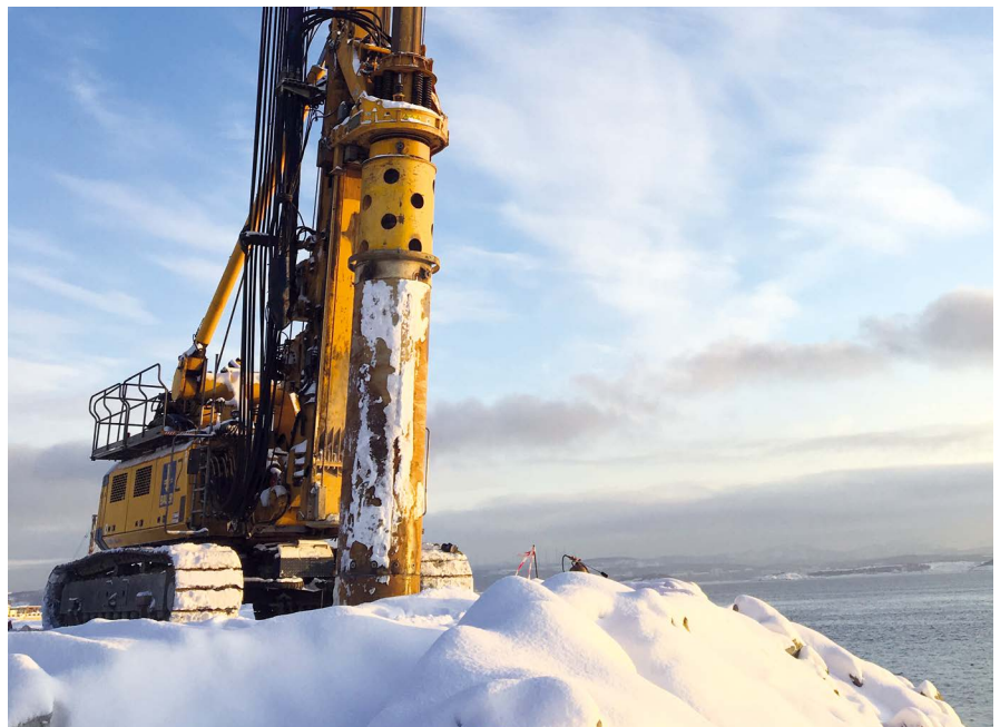
Russland Für ein neues Zentrum für Seebauten im russischen Murmansk führte Bauer insgesamt 2.540 lfm Bohrpfähle mit bis zu 32 m Länge aus. Die Arbeiten waren nach 50 Arbeitstagen abgeschlossen. oben
