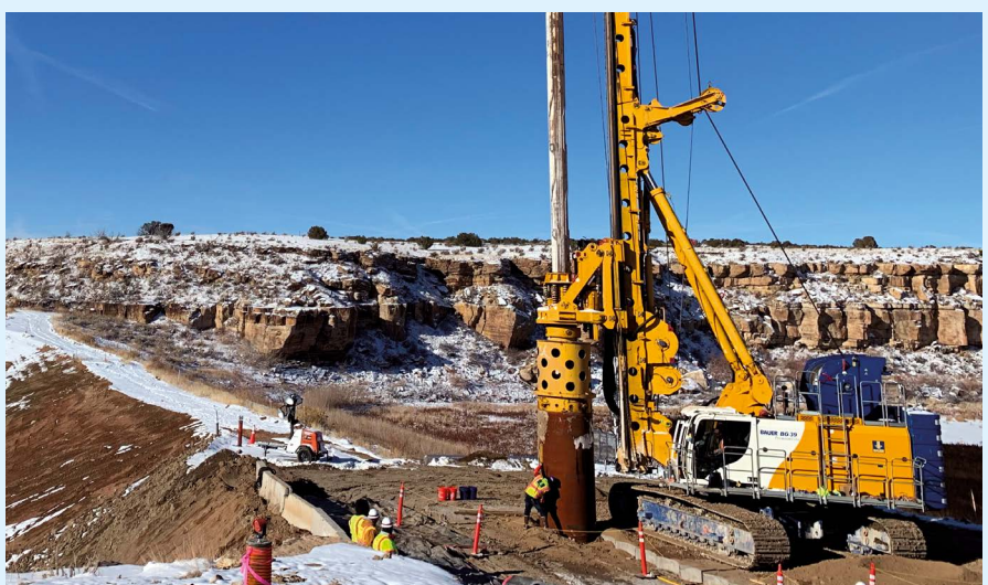
USA Der Teller Dam befindet sich innerhalb des US-Armee-Stützpunkts Fort Carson in der Nähe von Colorado Springs. Bauer wurde mit der Abdichtung des Damms beauftragt und führt zu diesem Zweck rund 1.160 m 2 überschrittene Bohrfahlfwand sowie rund 1.760 m 2 Dichtungsschleier aus. oben
