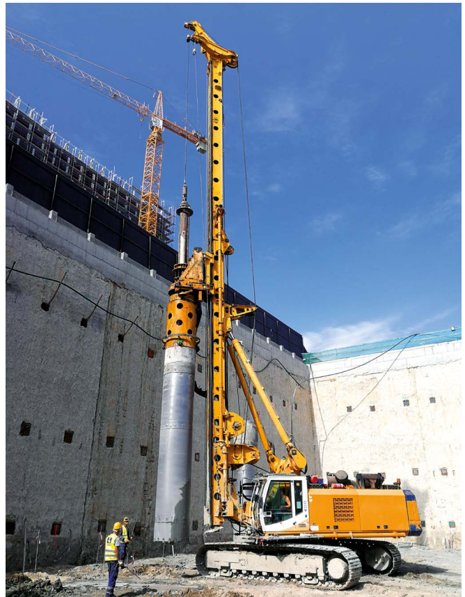
Ungarn Für eine neue Firmenzentrale in der Innenstadt von Budapest wurden 7.900 m 2 Schlitzwand bis in eine Tiefe von 22 m hergestellt und in drei Reihen mit 489 Ankern gesichert. Zusätzlich wurden 135 Pfähle abgeteuft. unten
