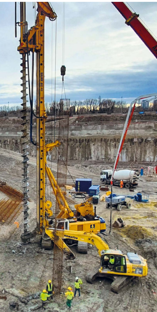
Russland Für ein neues Zentrum für Seebauten im russischen Murmansk führte Bauer insgesamt 2.540 lfm Bohrpfähle mit bis zu 32 m Länge aus. Die Arbeiten waren nach 50 Arbeitstagen abgeschlossen. oben
