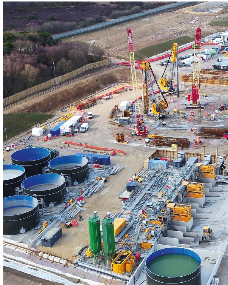
30 Jahre MAT: Im Frühjahr 2020 ein Grund zu Feiern – auch für die Mitarbeiter (oben). Egal ob Separationsanlage, Bentonitmischer oder Pumpen: BAUER MAT Slurry Handling Systems liefert alles aus einer Hand, wie auch hier auf einer Baustelle in England (rechts).
