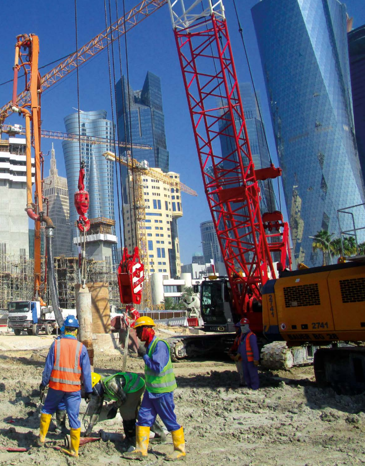
Katar Mithilfe einer BG 40 und einer BG 28 wurde eine Bohrpfahlwand bestehend aus insgesamt 112 Pfählen für eine Fußgängerunterführung in Doha hergestellt. links
