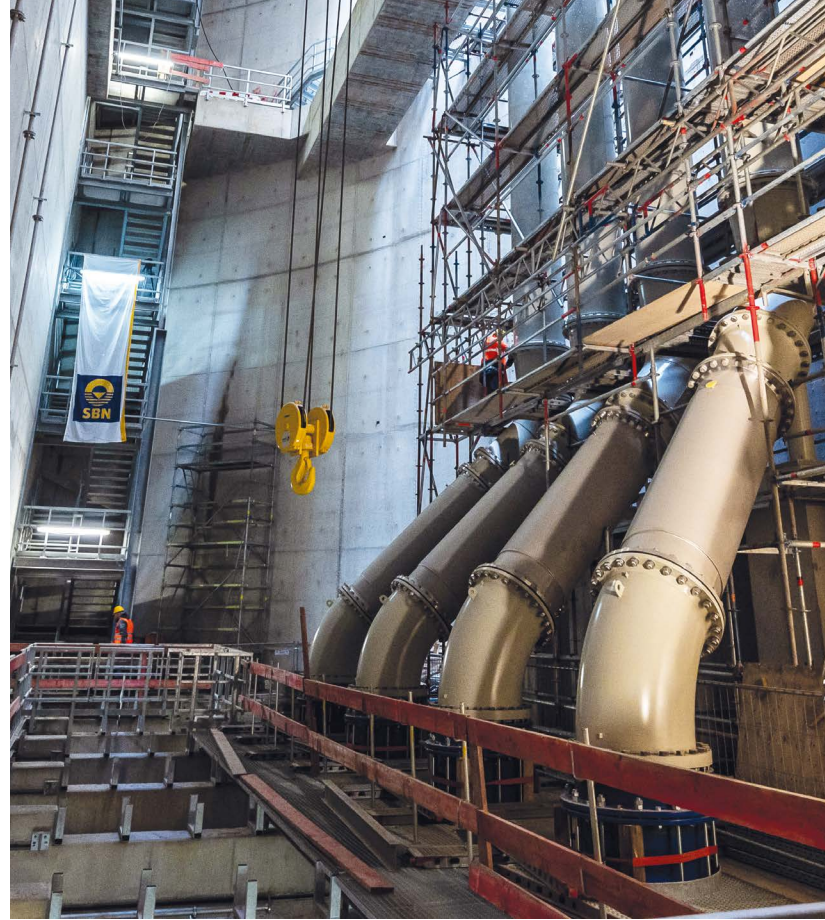
Die Montage der druckseitigen Verrohrung im Pumpwerk Oberhausen erfordert höchste Präzision (links), ebenso wie die Rohrleitungs montage mit Wärmetauscher (unten).
