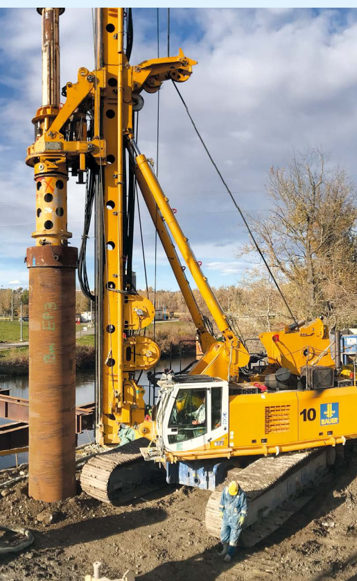
USA Der Teller Dam befindet sich innerhalb des US-Armee-Stützpunkts Fort Carson in der Nähe von Colorado Springs. Bauer wurde mit der Abdichtung des Damms beauftragt und führt zu diesem Zweck rund 1.160 m 2 überschrittene Bohrfahlfwand sowie rund 1.760 m 2 Dichtungsschleier aus. oben
