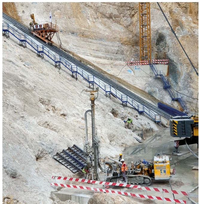
Libanon Der Jannah Dam nordöstlich von Beirut dient als Wasserspeicher der Region. Zur Abdichtung des Damms und zur Verpressung des Felsens an hochbelasteten Fundamentabschnitten führt Bauer rund 25.650 m an Injektionen aus. oben
