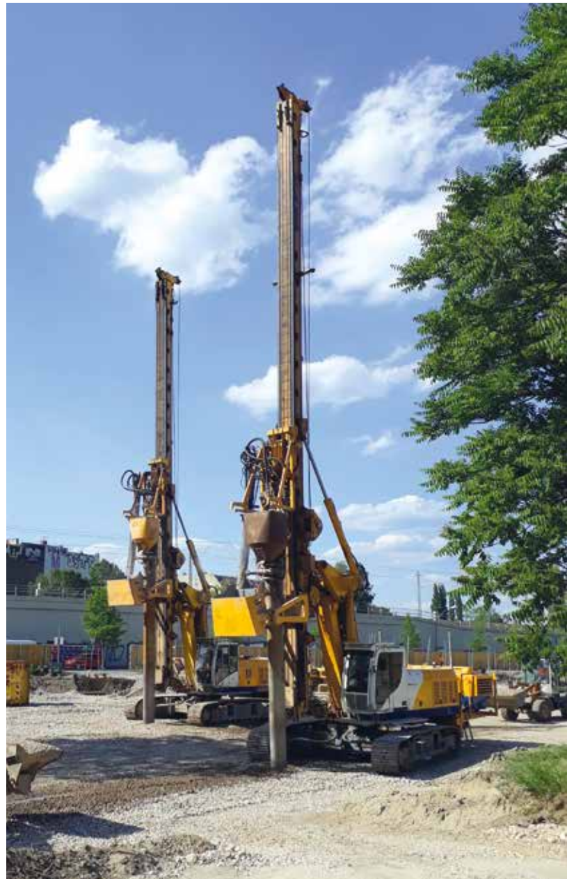
Bei frostigen Temperaturen wurden in Jena mit einer BG 24 bis zu 27 m lange Gründungspfähle mit 880 mm Durchmesser abgebohrt. Die Ausrüstung der Pfahlbewehrung mit geothermischen Leitungen sowie deren Verlegung samt Verteilereinheiten waren Auftragsbestand. links
