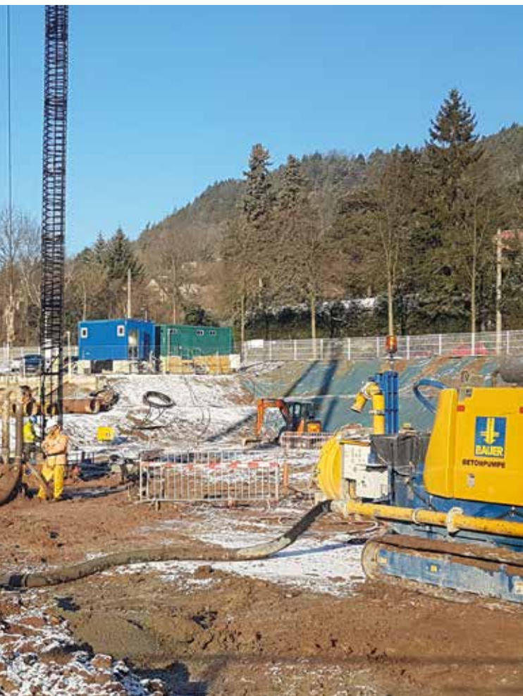
Bei frostigen Temperaturen wurden in Jena mit einer BG 24 bis zu 27 m lange Gründungspfähle mit 880 mm Durchmesser abgebohrt. Die Ausrüstung der Pfahlbewehrung mit geothermischen Leitungen sowie deren Verlegung samt Verteilereinheiten waren Auftragsbestand. links
