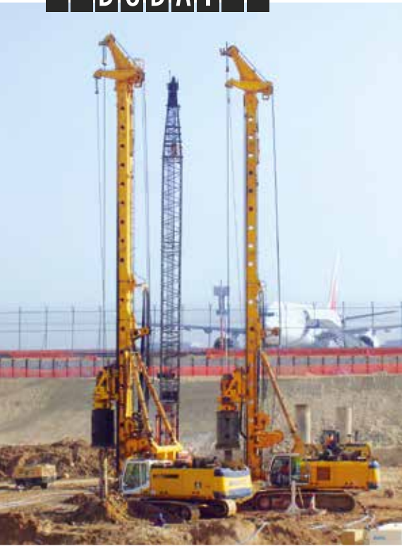
In Dubai erhielt Bauer über Jahrzehnte immer wieder Aufträge zur sukzessiven Erweiterung des International Airports.
