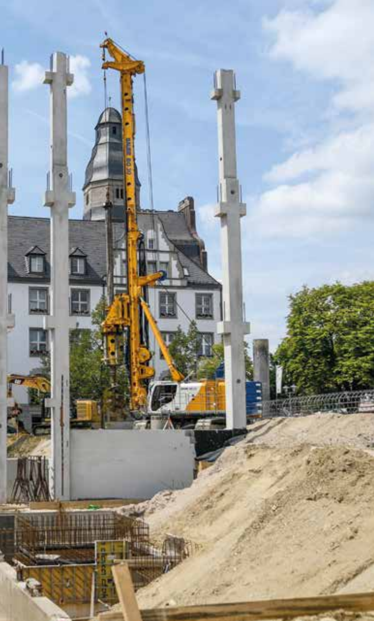
Für ein mehrstöckiges Bürogebäude in Berlin wurde eine Baugrundverbesserung mittels Rüttelstopfverdichtung bis in 13,5 m Tiefe vorgenommen. Eingesetzt wurden zwei Geräte des Typs BF13. unten
