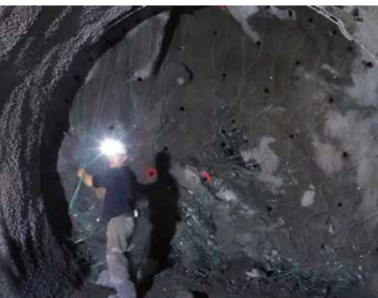
Verdrahtung der Zünddrähte für die Sprengung.
