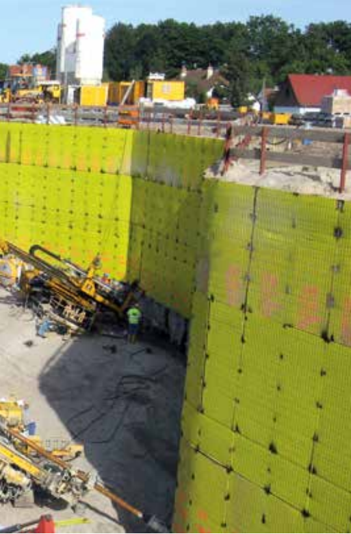
Die Spundwände der Dichtwand für die neue Schleuse Wusterwitz wurden mit dem Material Pecafil verkleidet. links und unten
