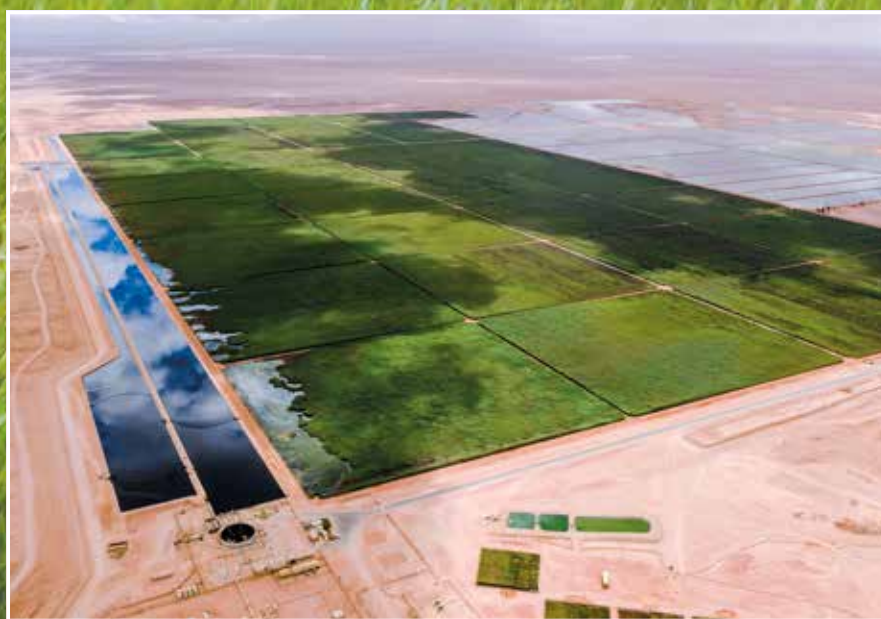
Bereits seit 2011 wächst das Schilf im ersten Abschnitt der Pflanzenkläranlage. (großes Bild). Mittlerweile erstreckt sich die Anlage auf einer Fläche von insgesamt 10,5 km 2 (kleines Bild).
