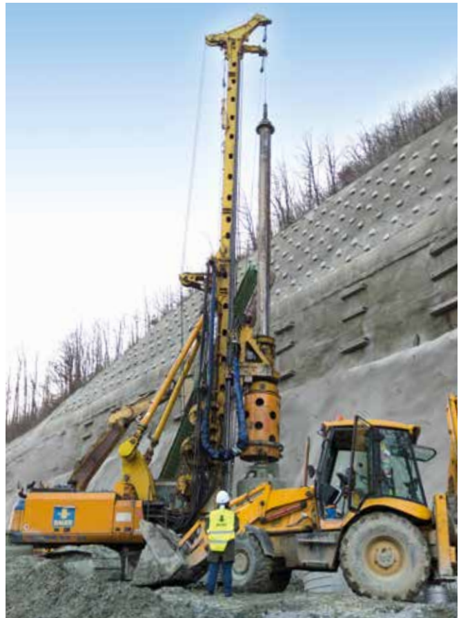
Bulgarien Für einen Brückenabschnitt der Autobahn E 75 nahe dem serbischen Predejane wurden zwischen November 2017 und März 2018 insgesamt 700 m teilverrohrte Pfähle von der bulgarischen Bauer-Mannschaft mit einer BG 24 ausgeführt. oben
