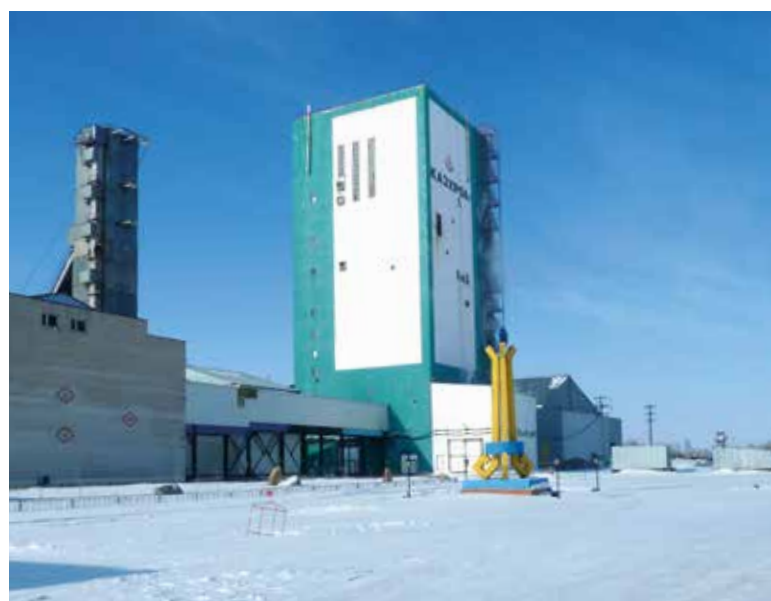
Schacht und Förderturm in Chromtau.
