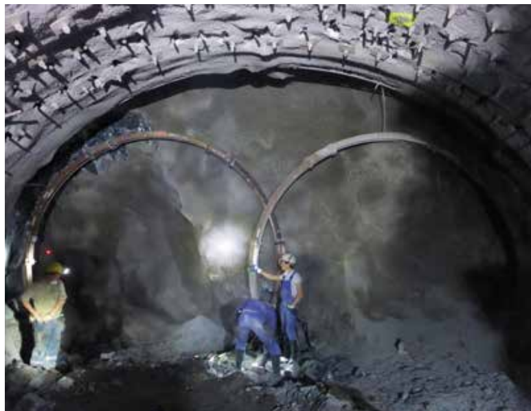
Großer Querschnitt im Bereich eines Streckenabzweigs.
