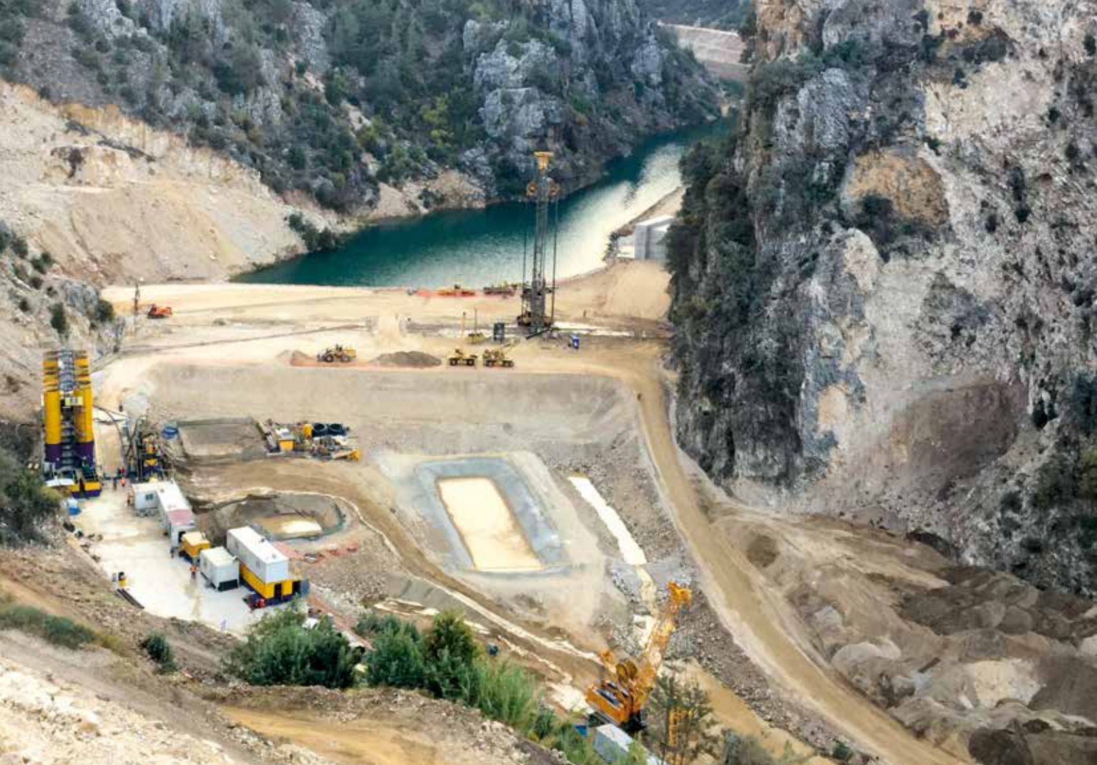
Libanon Am Jannah Damm wurde Bauer mit der Dammertüchtigung beauftragt. Auf einer Strecke von 123 m wurden gefräste Schlitzwandelemente als Betonitbeton-Dichtwand ausgeführt, die bis in 50 m Tiefe reichen. oben
