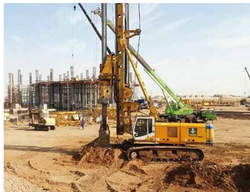
Saudi-Arabien In Dhahban, nahe Jeddah, wickelte Bauer für das Security Forces Medical Centre drei große Auftragspakete zwischen Februar 2017 und Juni 2018 ab. Dabei stellten zwei BG 40 und sechs BG 28 insgesamt acht Pfahltests, 2.000 Wandpfähle und 4.600 Gründungspfähle her. oben
