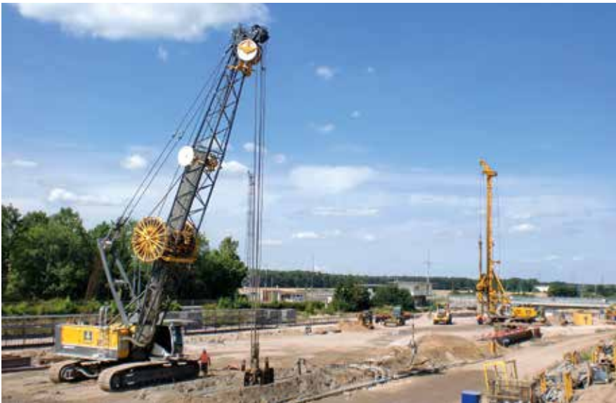
Im Frühjahr 2013 begannen die Spezialtiefbauarbeiten für die Schleuse Zerben. oben und rechts
