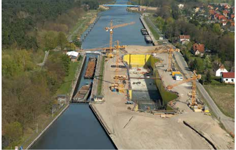
Die Spundwände der Dichtwand für die neue Schleuse Wusterwitz wurden mit dem Material Pecafil verkleidet. links und unten
