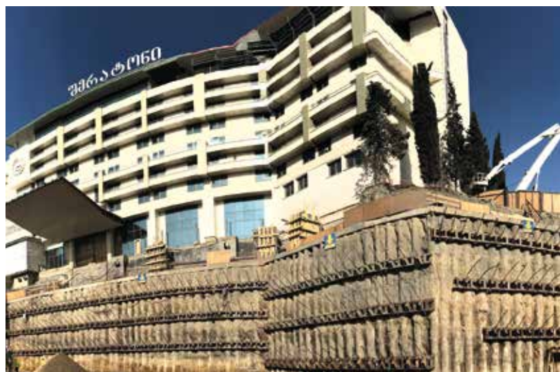
Georgien Für den Bau von Tiefgarage und Casino am Sheraton Hotel in Tiflis wurde Bauer als Nachunternehmer für die bereits hergestellten Pfahlwände mit der Verankerung in drei Lagen beauftragt. oben
