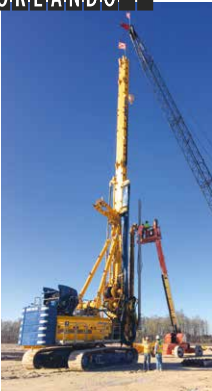
Gründungsarbeiten für ein Parkhaus am Orlando International Airport, USA.
