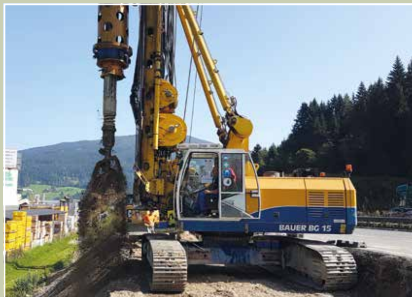
Österreich An der Tauernautobahn A 10 entstehen südlich von Salzburg Lärmschutzwände, die auf insgesamt 9.900 m Bohrpfählen gegründet werden. Zum Einsatz kamen zwei Bohrgeräte BG 20 H und BG 15. oben
