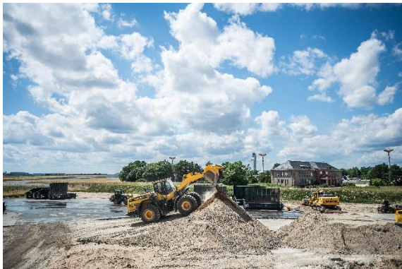
(1) Bauer Resources saniert das Gelände des ehemaligen Tanklagers Nord am Flughafen Berlin-Schönefeld.
