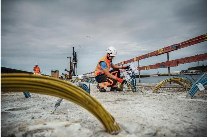
(3) In jede der fast 320 Bohrungen wurden 18 bis 20 Ventile mit einem vertikalen Abstand von 0,5 m eingebaut.
