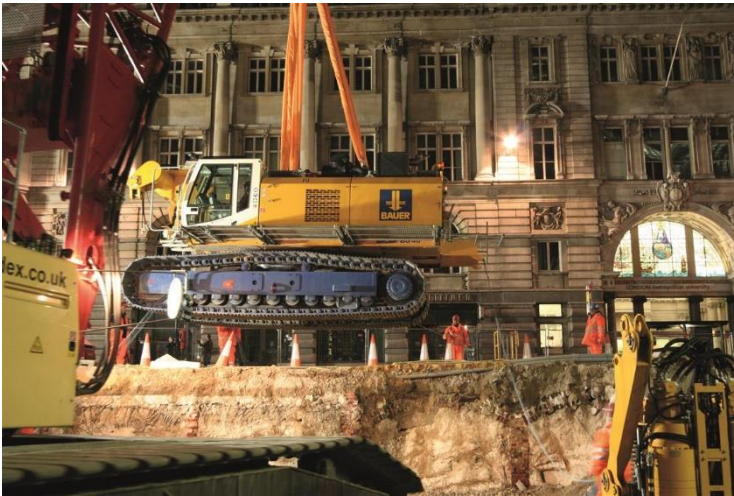
(2) Kernstück der Spezialtiefbau-Arbeiten für den Moorgate Schacht an der Liverpool Street Station war die Ausführung eines 60 m tiefen Schachts.
