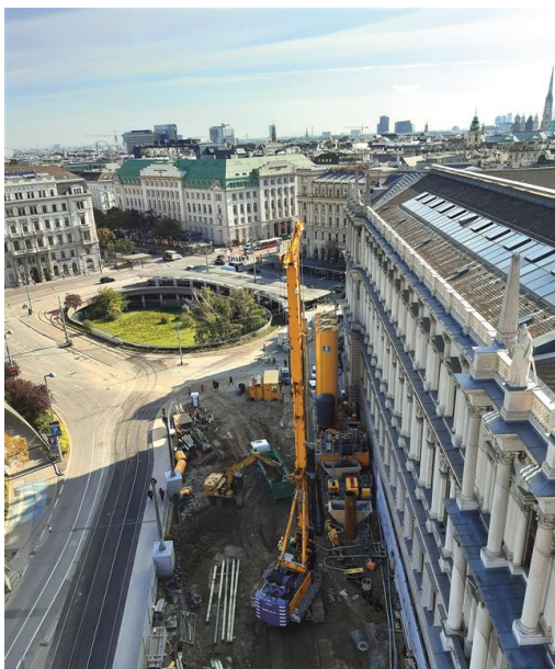
(3) Eine BAUER BG 45 bohrte beim Baulos U2/22 Absprungbauwerk am Schottentor.
