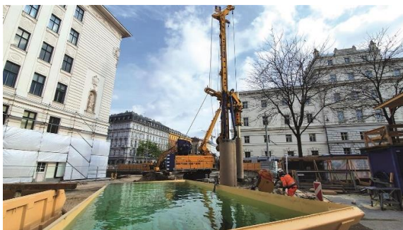
(2) Beim Baulos U5/2 Schacht Frankhplatz Nord kam eine BAUER BG 39 zum Einsatz.
