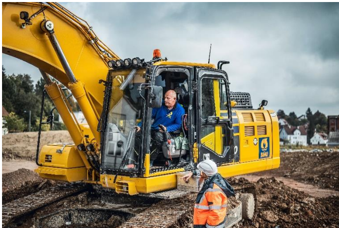
(2) Nach vorbereitenden Maßnahmen begannen im August der Aushub und die teilweise Separation des Bodens.
