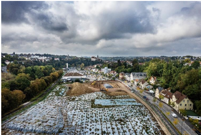
(1) Der Bereich Bauer Umwelt der BAUER Resources GmbH führt auf dem Areal einer ehemaligen Gerberei Bodensanierungsarbeiten durch und stellt die Baugrube für den Neubau eines Pflegeheims her.
