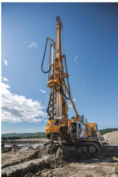
(2) Für die Herstellung einer überschnittenen Pfahlwand kommt eine BAUER BG 39 zum Einsatz.
