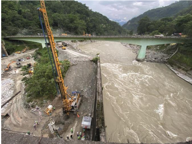
Bild: 2021-07_BAUER_Teesta VI Hydro Electric Project
