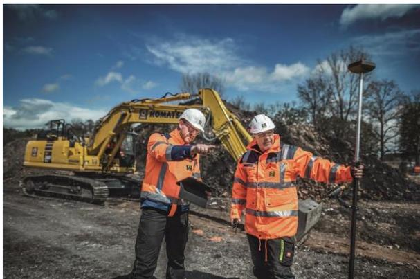
(2) Mittels Drohne und Roverstab wurde das Areal zentimetergenau vermessen.
