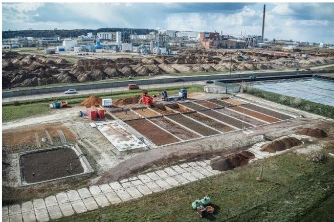
(1) Die Grundwasserreinigungsanlage der Bauer Umwelt in Leuna reinigt in 18 hintereinander geschalteten Filterbecken das verunreinigte Wasser rein biologisch mithilfe von Mikroorganismen.
