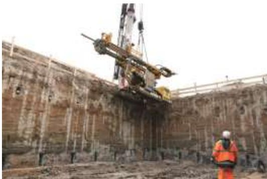
(2) Die Herstellung der Verpressanker mit vier bis sechs Litzen und einer Länge von rund 17 m erfolgte im drehschlagenden Verfahren.
