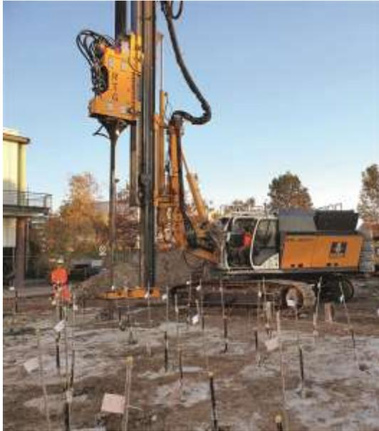
(1) Die Abdichtung der Baugrubensohle zu den grundwasserführenden quartären Sanden wurde durch eine tiefliegende BAUER LWS Silikatgelsohle realisiert.
